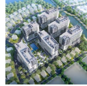
Khu nhà ở An Sinh Tỉnh Bình Dương Đang thực hiện
