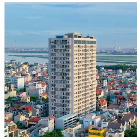
Chung cư Pakexim 2 Tp. Hà Nội Đã hoàn thành năm 2016
