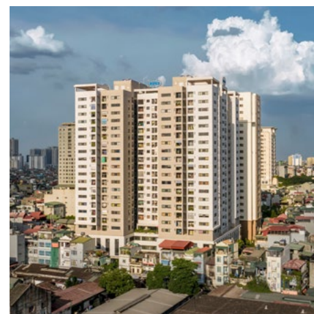
Tòa nhà hanel - HUD3 Tp. Hà Nội Đã hoàn thành năm 2019
